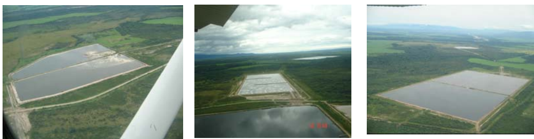
Vistas aéreas de reservorios anaeróbicos, pileta de aireación y piletas de estabilización existentes
